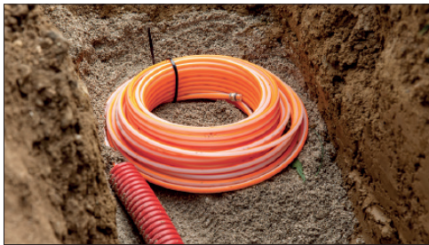
Abb. 1: aufgerollter Bund Glasfaser-Mikrorohr
