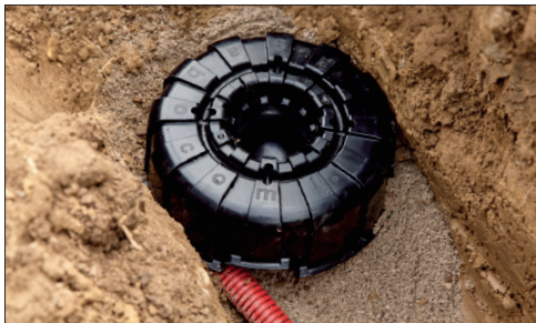
Abb. 2: Abdeckung über der vergrabenen Leerverrohrung
